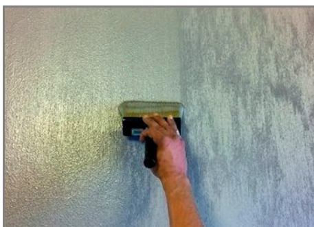
Fase 5 - Se lo desiderate, dopo alcune ore a parete asciutta applicare una seconda mano per rendere l'effetto più pieno ed omogeneo mantenendo il senso verticale della applicazione e disegnare FilidiSeta sulla parete
